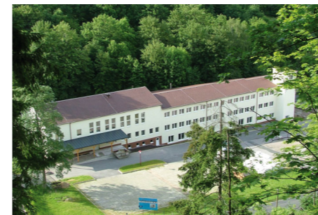
Werk 3 – Unterweißbach Transformatorenbau
