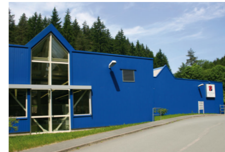
Werk 2 – Mellenbach Elektronikfertigung
